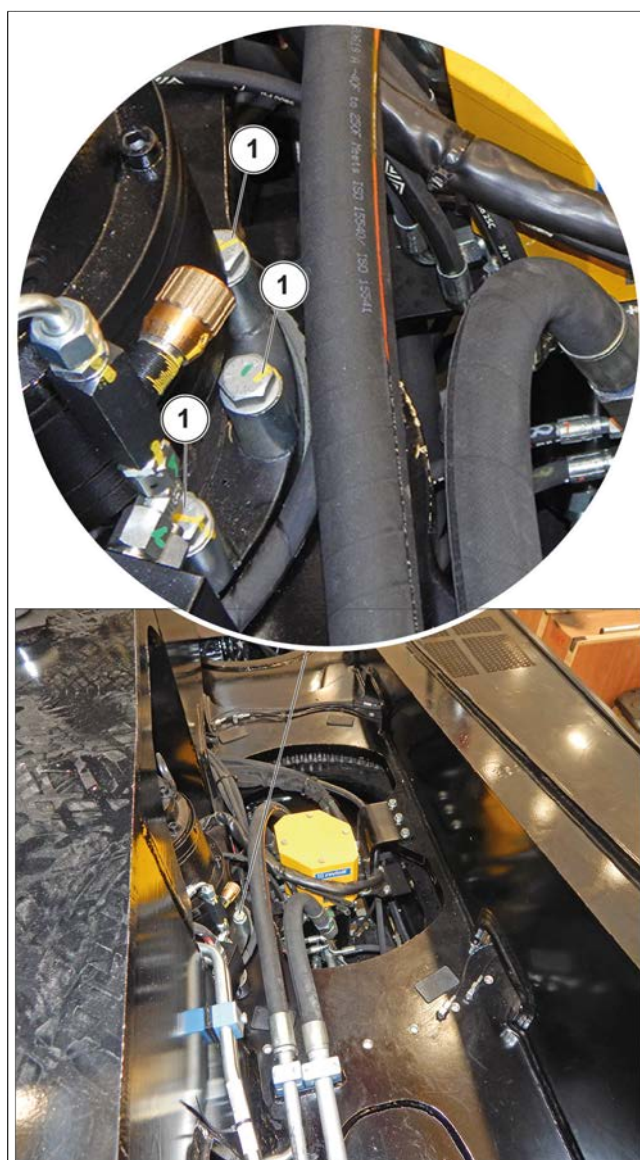
Figura 159: Verificarea etanșeității șurubului de fixare a reductorului de rotație
